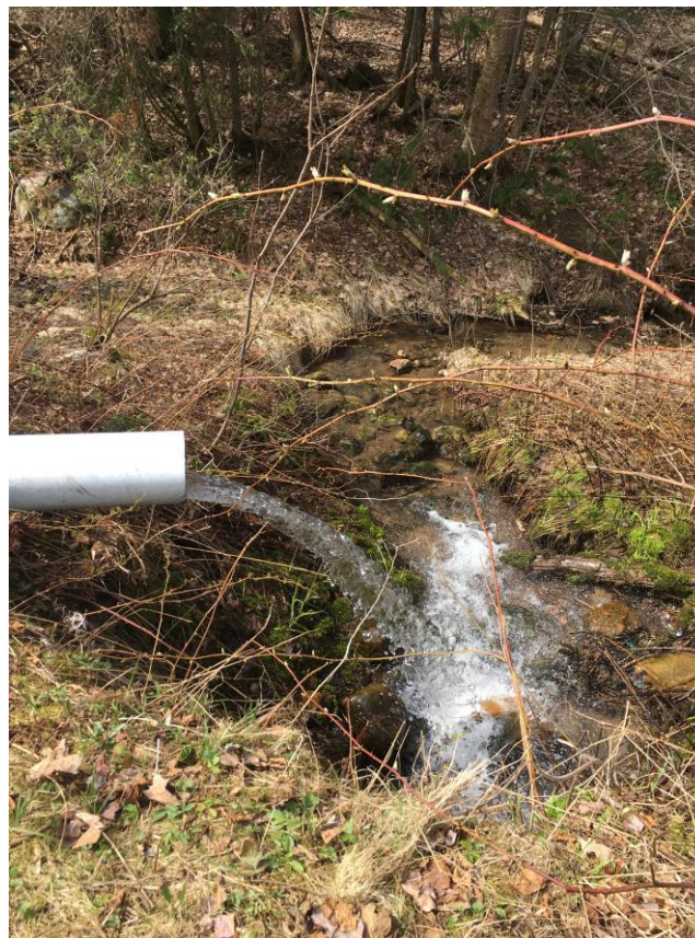
Figure 8 : Surplus d'eau s'écoulant par le trop-plein (mai 2019)
