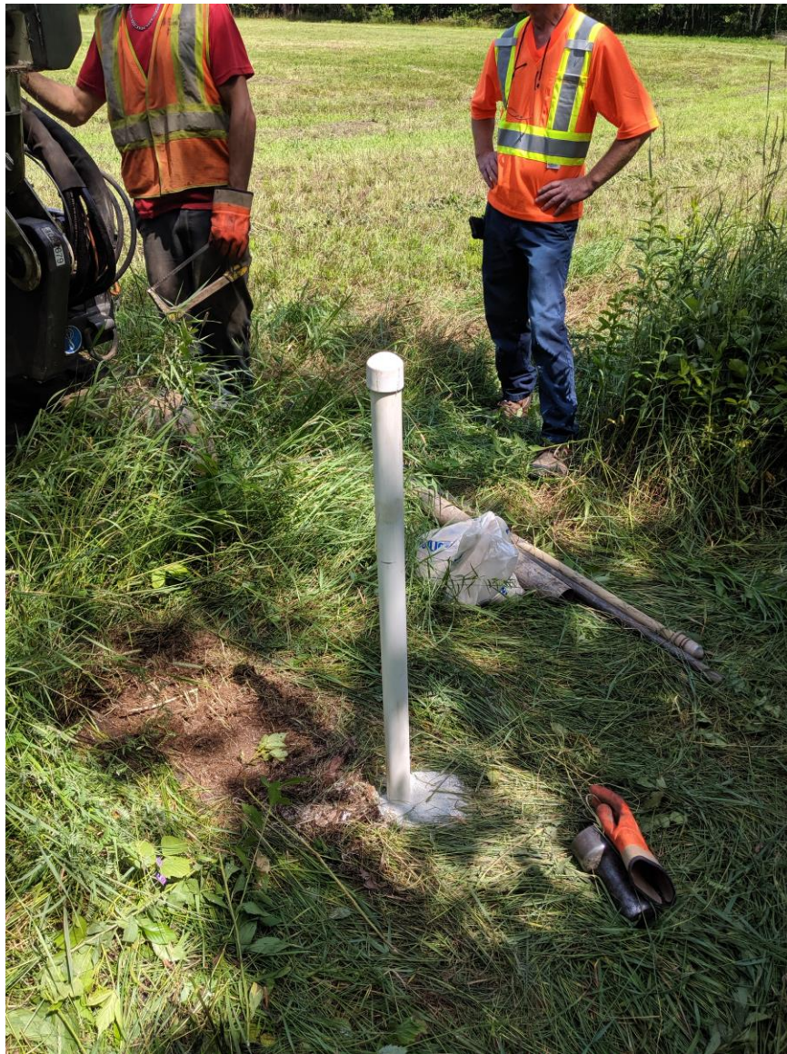
Figure 4 : Aménagement d'un piézomètre (PZ-7)
