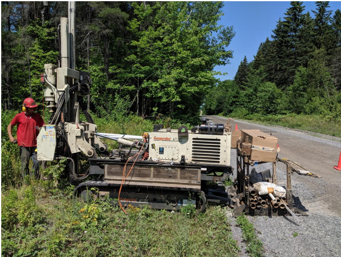
Figure 3 : Type de foreuse utilisée pour le forage des piézomètres (forage de PZ-9)
